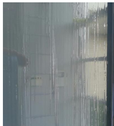
defecten kwastapplicatie
